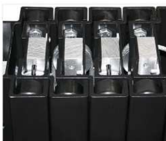
Sistema de reenvío con poleas de acero.
